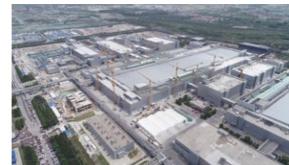
三星(中国)半导体有限公司二期项目建设现场
