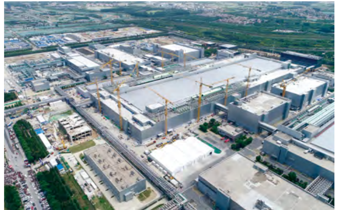
三星（中国）半导体二期项目建设现场
